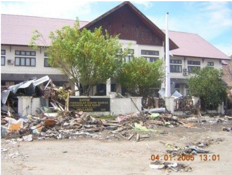
Kondisi Gedung DPRK Aceh Barat pasca tsunami.
